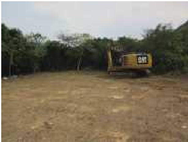
写真6 重機による伐開作業風景
