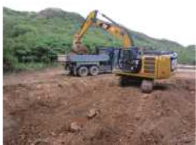
写真7 重機による表土掘削作業風景
