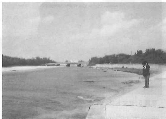
写真4 渡口入江水道東口。ビーチロックや砂丘などを形成
