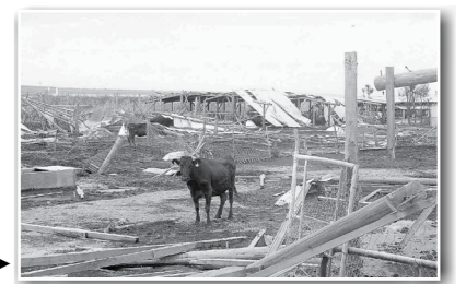
暴風により倒壊した牛舎
