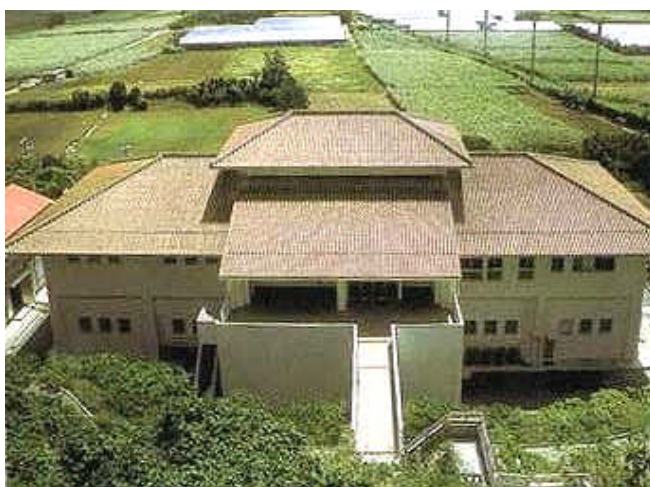
【宮古島市袖山浄水場硬度低減化施設】
