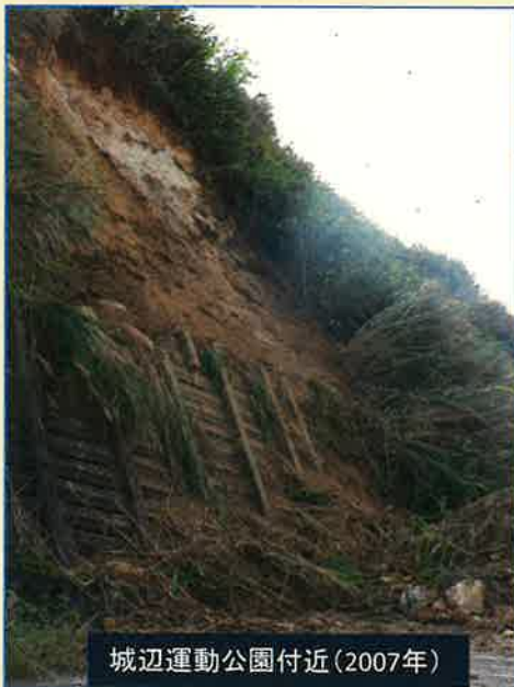
のり面崩壊による道路封鎖
