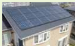
太陽光パネル
